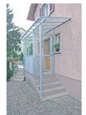
Der Hauseingang ist geschützt gegen Wind und Wetter.
