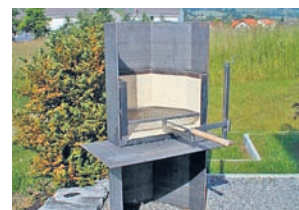
Feuerstelle mit Schwenkgrill, ausgekleidet mit Schamottplatten.
