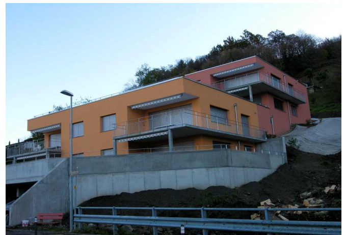
Ansicht von der Strasse
