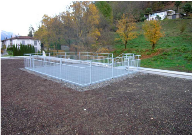
Geländer auf dem DG. Feuerverzinkt.
