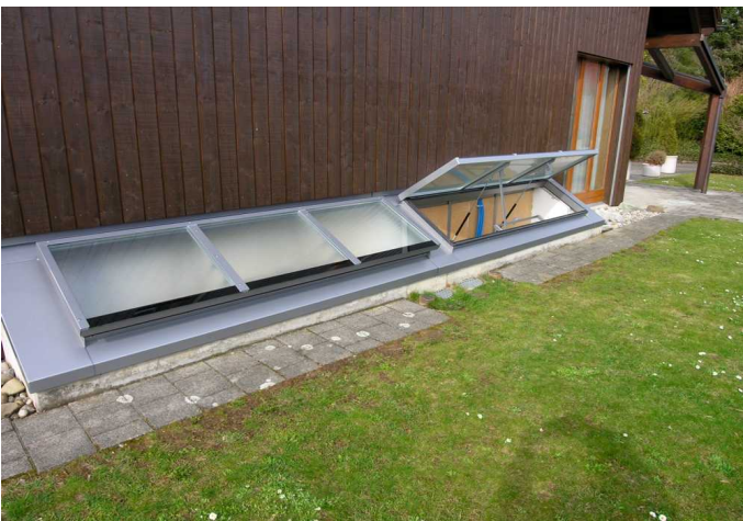
Pro Flügel helfen 2 Gasdruckferdern beim öffnen
