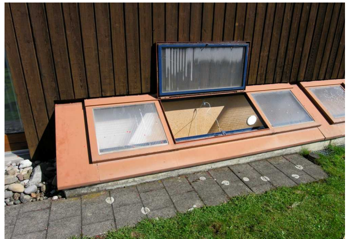
Die Füllungen sind Plexiglasdoppelstegplatten
