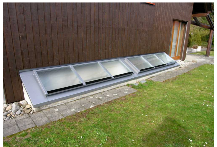
Die neue Lichtschachtverglasung mit Isolierglas
