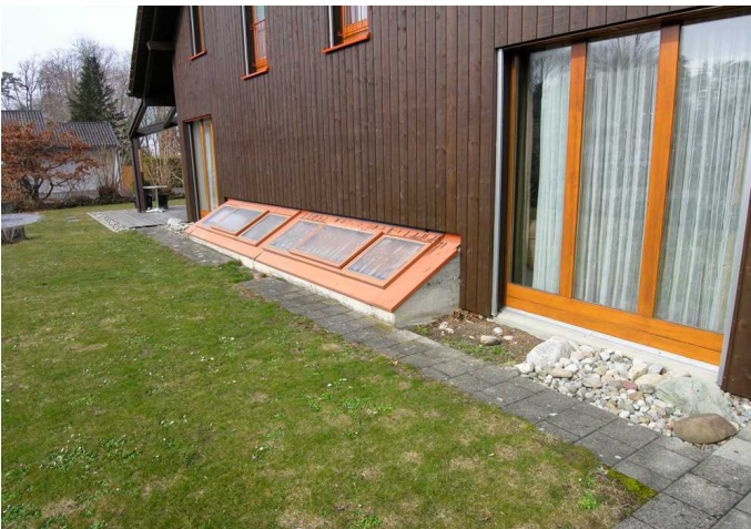
Die bestehende Lichtschachtverglasung wurde aus Stahlblech angefertigt.
