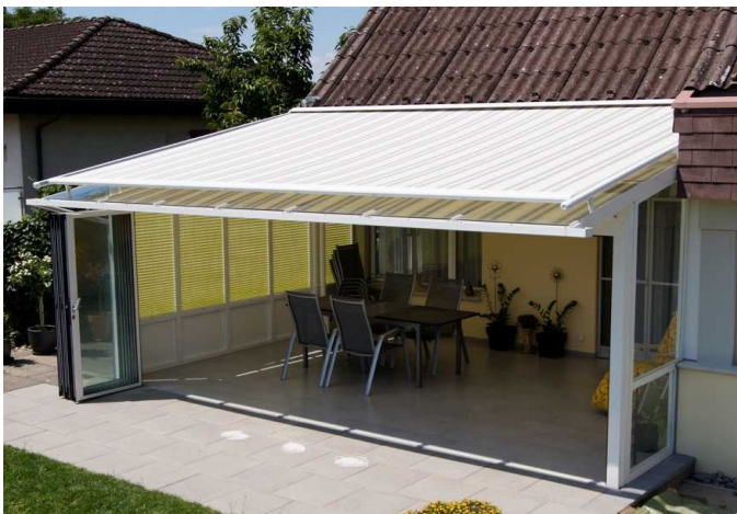
Das Dach mit der Wintergartenbeschattung
