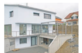
Die Pergola und Steg mit Geländer wurde kürzlich in Gachnang montiert.
