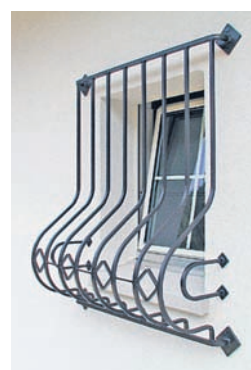
Fenstergitter als Schmuck und Einbruchschutz.
